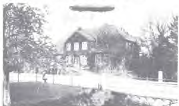
Bild 3.37: Das vorige Pastoratsgebäude
