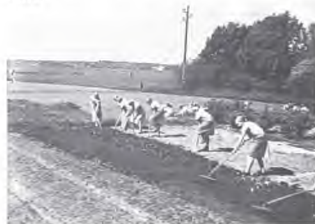
Bild 8.10: Arbeit im Lagergarten hinter dem Haus
