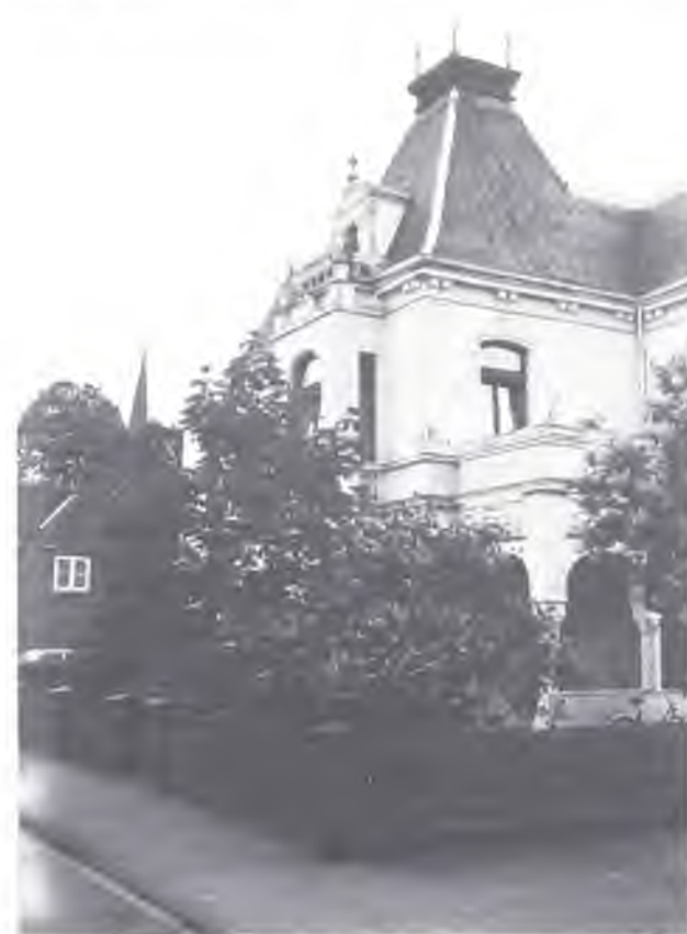
Bild 8.6: Das Aussehen des von älteren Eddelakern noch heute "Apotheke" genannten Gebäudes hat sich wenig geändert.
