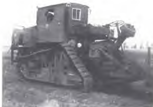
Bild 11.17: Eine Püttmaschine im Einsatz
