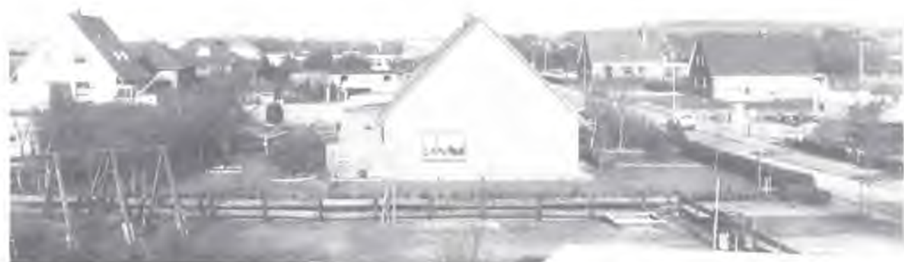
Bild 12.36: Im Neubaugebiet Kampweg wird emsig gebaut, um die letzten Lücken mit Einfamilienhäusern zu füllen. Im Hintergrund ist die Grundschule sichtbar.
