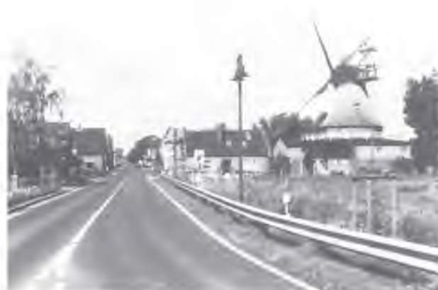
Bild 3.7: Südliche Orsteinfahrt und Mühle
