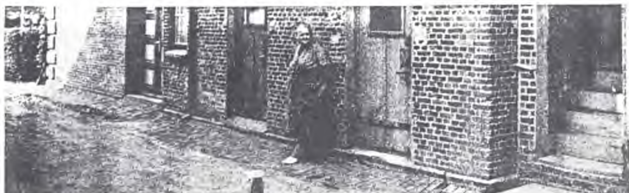
Bild 6.6: Hinter den beiden schmalen Türen mußten Gefangene einsitzen. Links und darüber: Wohnungen für den Gerichtsdienner und den Gefangenenwärter.
