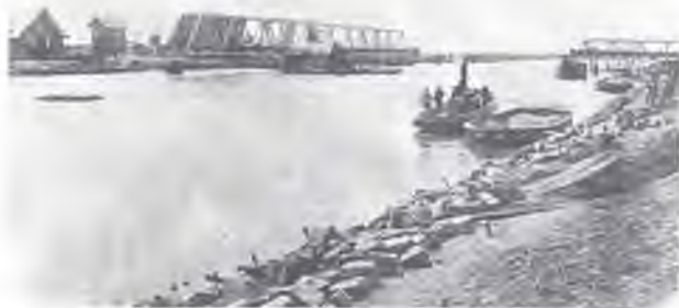
Bild 7.29: Eisenbahn-Drehbrücke bei Taterphal in geöffneter Stellung, das Verkehrshindernis vieler Jahre im südwestlichen Kanalabschnitt (WSA Brunshüttel)
