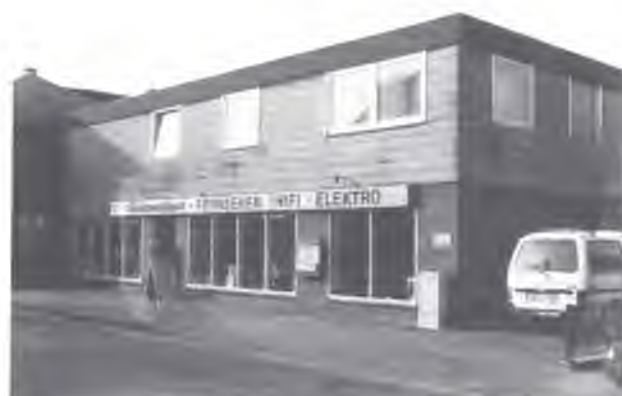
Bild 9.38: Die Firma Feichtenschlager
