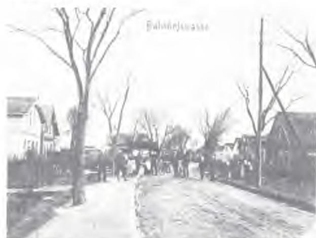
Bild 3.43: Bahnhofstraße 1910 mit Ulmenbestand, einseitigem Fußweg und beidseitigen Flethen
